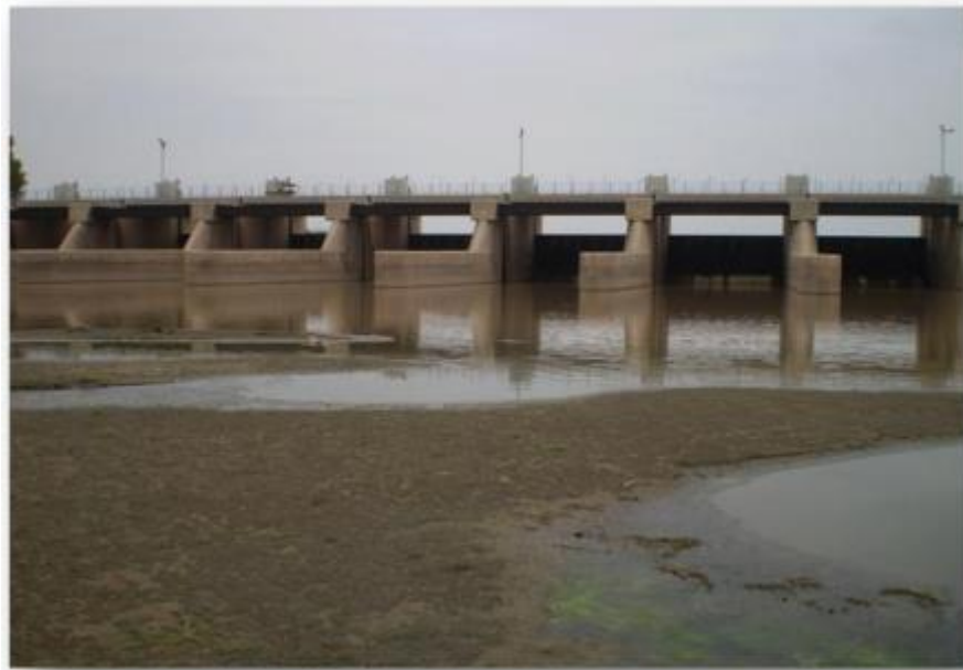
Fig. 3: Sindhnai Barrage on Ravi
